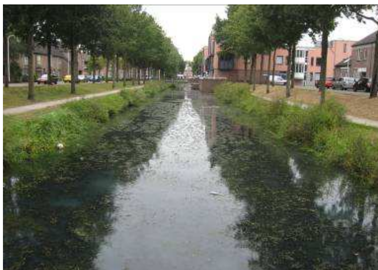
Foto 9. Overzicht van de waterloop aan de Boxmeersingel op 14 september gezien vanaf de voetgangersbrug 100 m benedenstrooms van de Borculolaan. Duidelijk zichtbaar is de blauw-grijze waas in het water.
