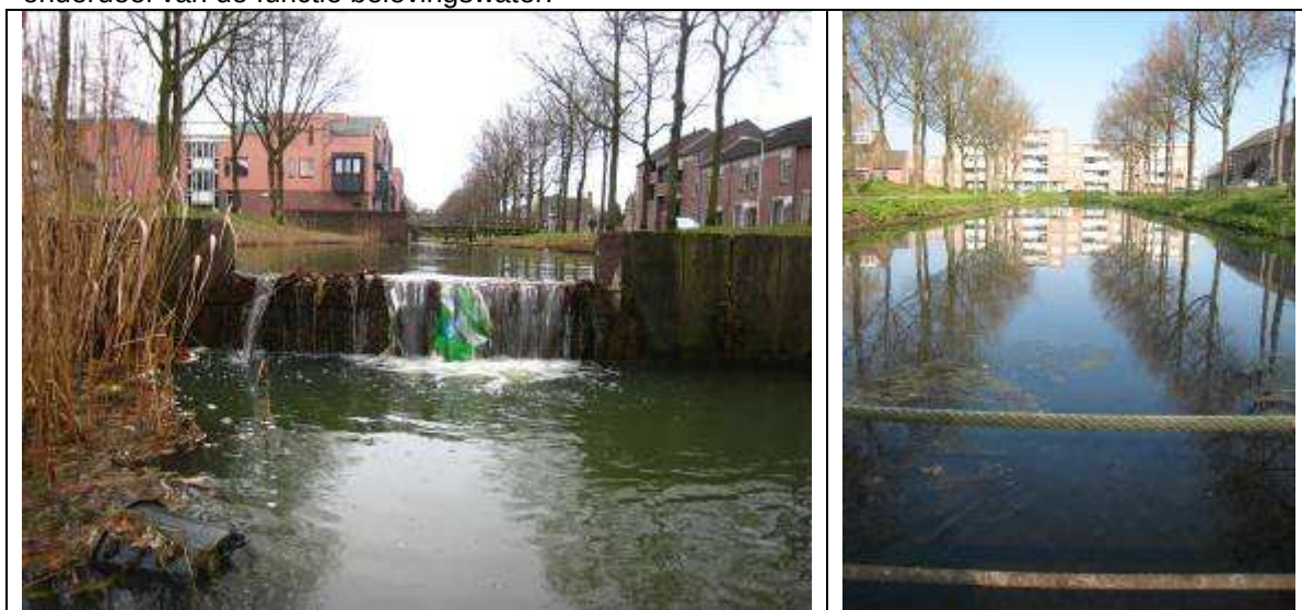
Foto 7 en 8. Links de houten stuwbalk/ -schot tussen de waterlopen aan de Boxmeersingel en Blaricumsingel. Rechts een overzicht van de waterloop aan de Blaricumsingel-Bakkumsingel.
